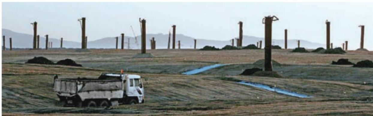
Suelo que cubre el sitio del Relleno Sanitario Metropolitano. Los tubos se construyen para capturar gas metano y usarlo en la generación de electricidad.
