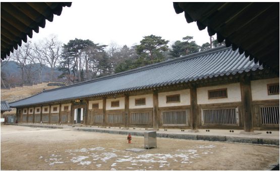
① 해인사 장경판전(1995년 등재, 장경판전 외관) 경상남도 합천군 소재 해인사 장경판전은 13세기에 만들어진 세계적 문화유산인 고려대장경판 8만여 장을 보존하는 보고로서, 해인사의 현존 건물 중 가장 오래된 건물이다. 원활한 통풍과 방습, 실내 적정 온도 유지, 판가의 진열 장치 등이 매우 과학적이며, 합리적으로 되어 있어 고려대장경판이 지금까지 온전하게 보존되고 있다.
